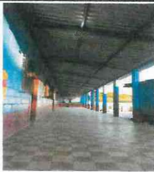
Foto 3: Reparación de cableado eléctrico
