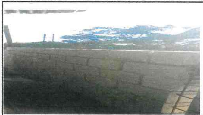
Foto 2: Reparación de muro perimetral
