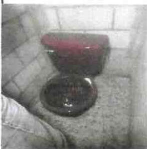
Foto 5: Sustitución de sanitarios
