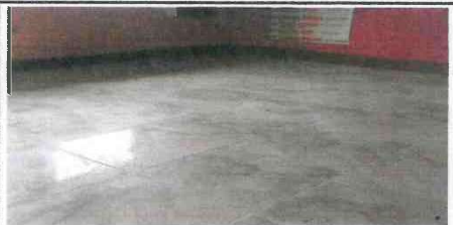
Foto 4: Sustitución de piso cerámico
